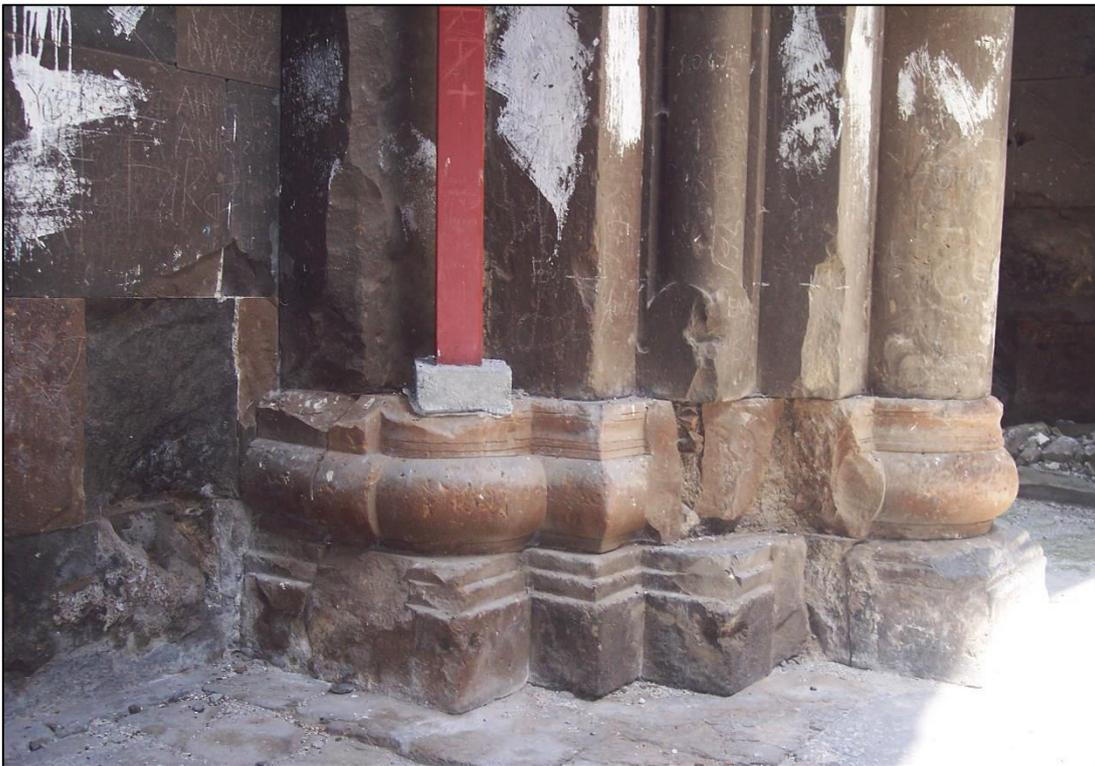
Abb. 40: BASIS EINES PFEILERS MIT MODERNER NOTREPARATUR. Foto: Prof. Annegret Plontke-Lüning.
